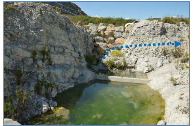
Exutoire du Bassin P26 (aval) - bassin intermédiaire et exutoire vers la route transversale sous le site
