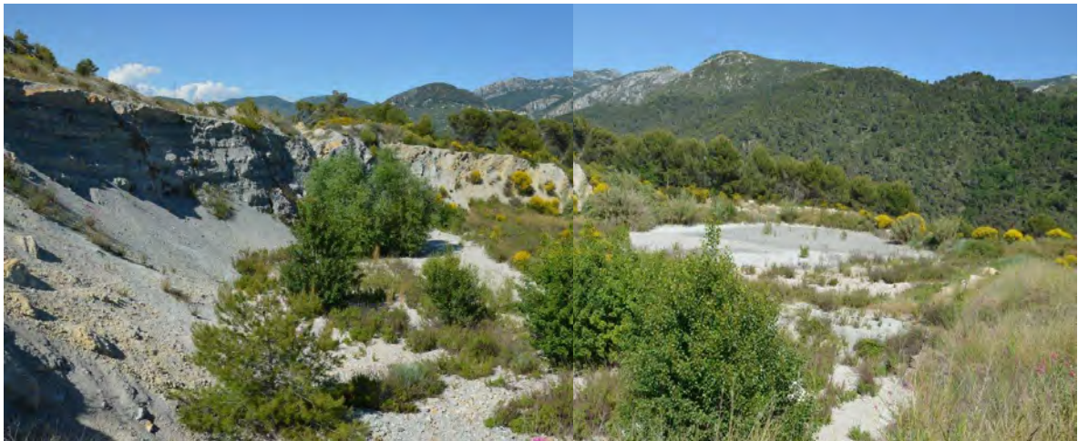
Vue générale des bassins de rétention du secteur Sud
